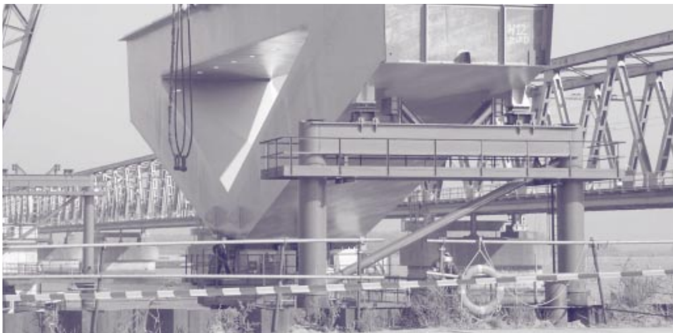
Brug Hollandsch Diep: plaatsing van hamerstuk.
